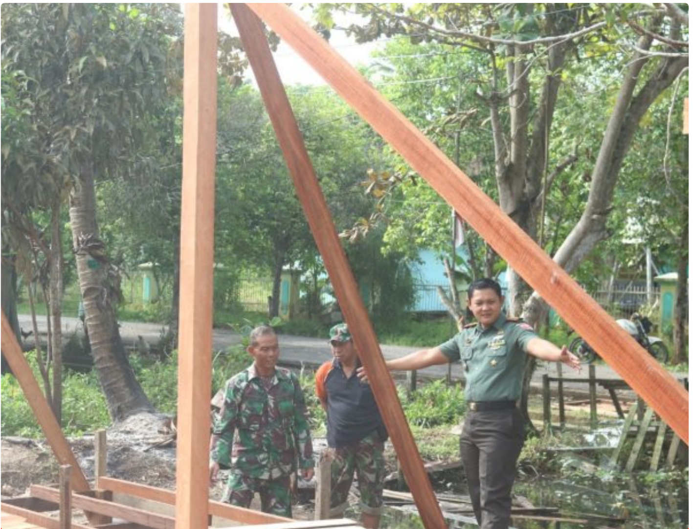
Dandim 1001/HSU-BLG Tinjau Pembangunan Rumah Dinas Prajurit Kodim
